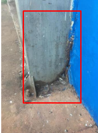
Foto4 – Corte e substituição chapa metálica.
