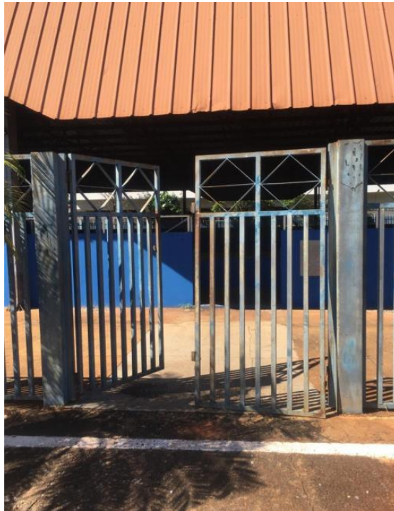
Foto2 - Troca das dobradiças portão metálico
