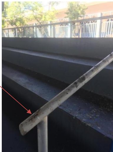
Foto5 – Escovamento de oxidações.
