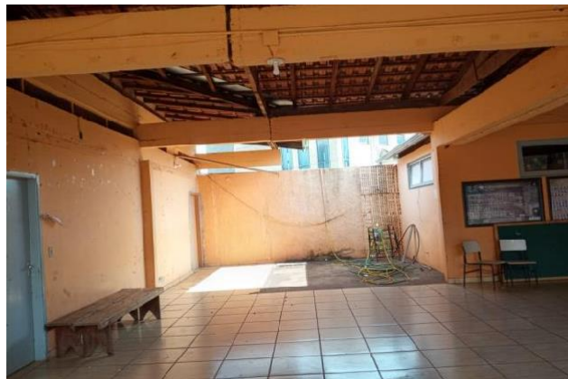
Foto 1 – Local ampliação cozinha, ladrão caixa d' água.
