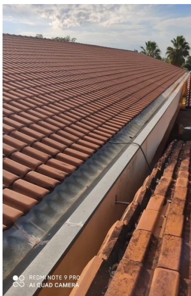
Foto 6 – Telhado a ser reformado.
